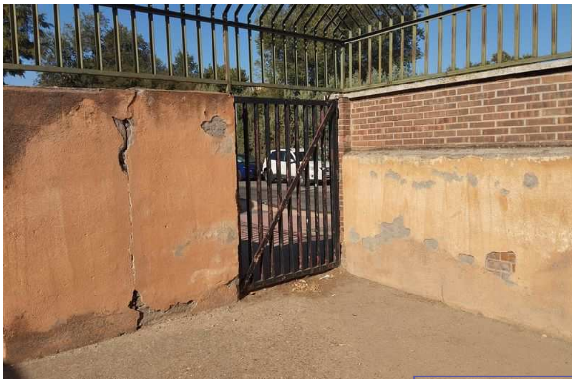
FOTOGRAFIA 10: Vista de humedades y agrietamientos de
