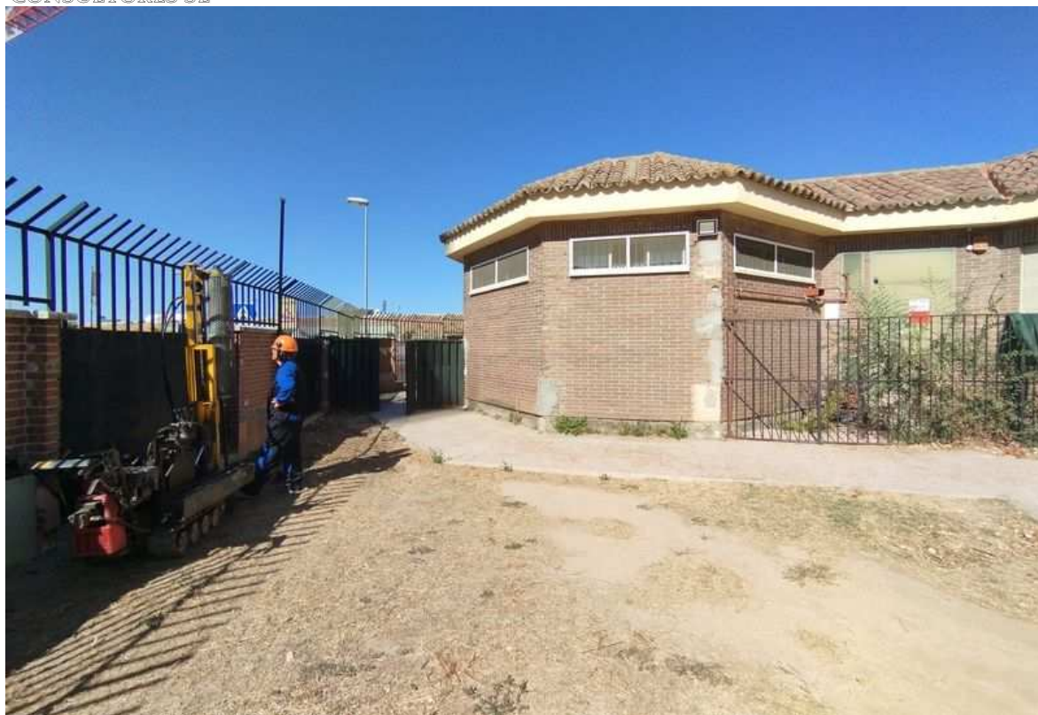
FOTOGRAFIA 7: Vista de la realización del Penetrómetro 3.
